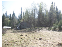
Stugan börjar bli i dåligt skick
